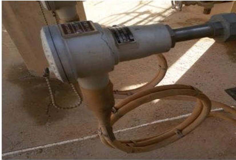
Figure II-11 : Transmetteur de température TE303.
