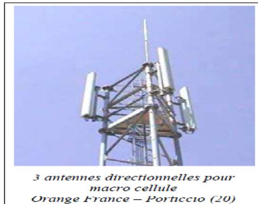
**Figure I.2 :** représente un exemple d'une macro BTS.
