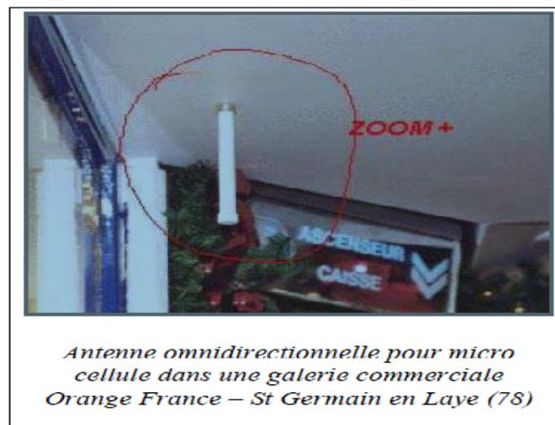
**Figure I.3 :** un exemple sur les micros BTS
