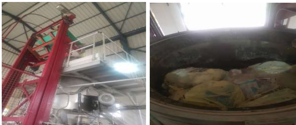
Figure 26: Le chargement des déchets
