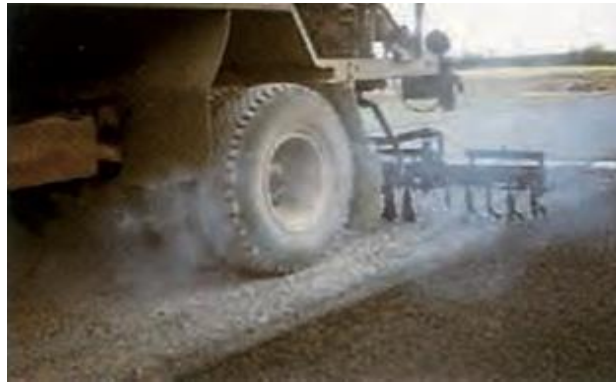
Figure VI.12. Répandage de l'émulsion
