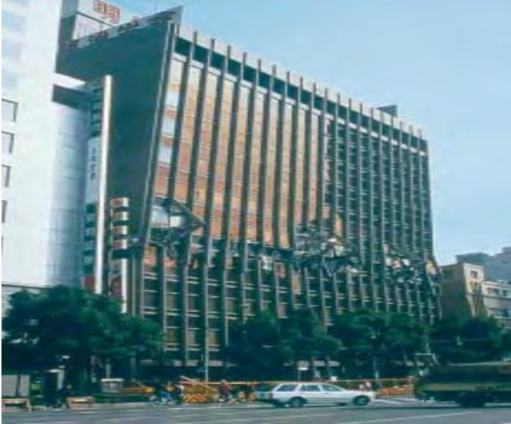
Figure I.5 : Image d'un immeuble présentant un étage souple ayant cédé suite à un séisme[30]
