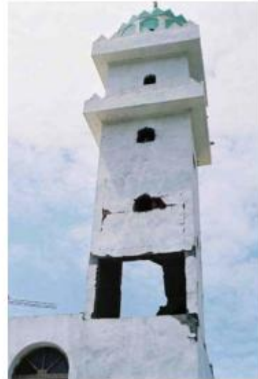
Figure I.8 : Dommages au niveau du minaret d'une mosquée à Zemmouri suite à une variation brutale de la rigidité [26].
