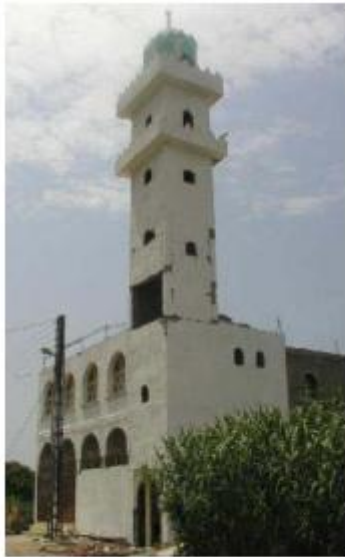
Figure I.8 : Dommages au niveau du minaret d'une mosquée à Zemmouri suite à une variation brutale de la rigidité [26].
