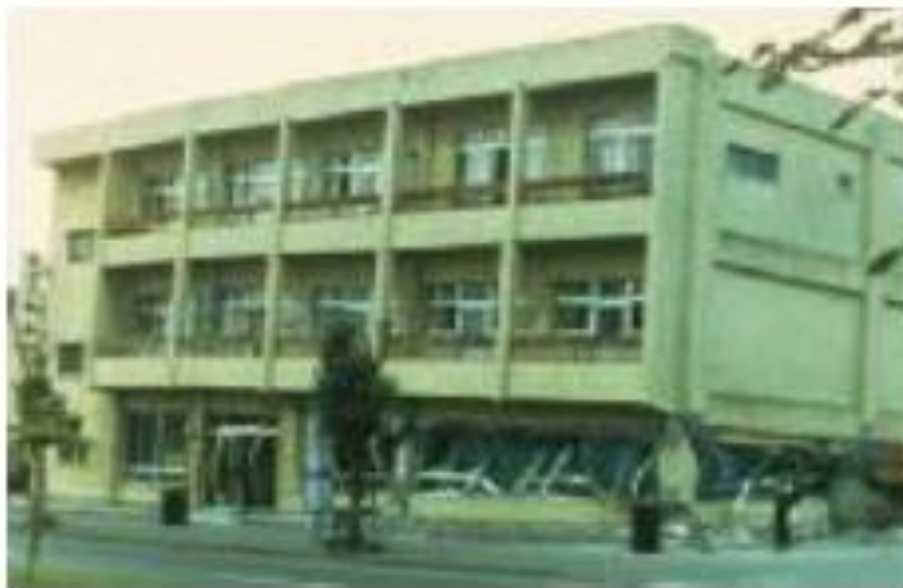
Figure I.7 : Dommages dus à la torsion du rez-de chaussée d'un immeuble (séisme Tokachi-Oki, Japon 1968) [31]
