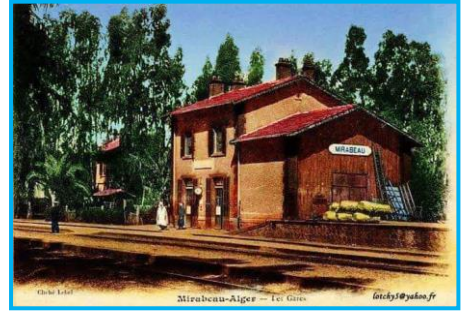
Photo 4: l'ancienne gare ferroviaire de DBK
