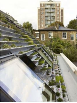
Photo 77: bacs agricoles sur toiture
