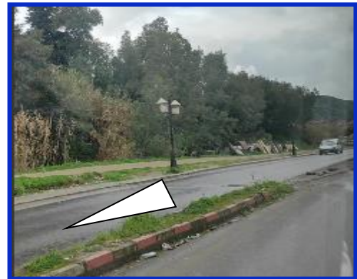
Figure 3: Accès Ouest vers la ville de DBK venant d'Alger à Tizi-Ouzou
