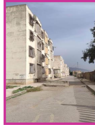
Photo 28: voie de la cité fethi
