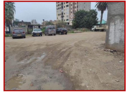
Photo 58 : place de l'ancien hôtel de ville démolie
