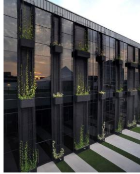
Photo 78 :bacs agricoles sur façade
