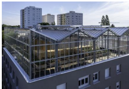
Photo 86: serre maraichère à Nantes
