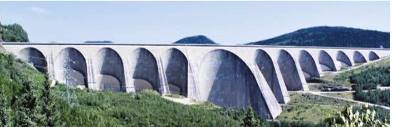
Figure 1.5 : Barrage à voûtes multiples [7].
