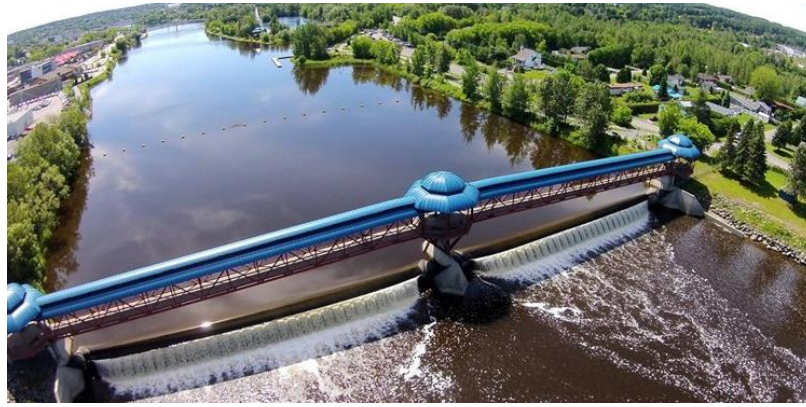
Figure 1.11 : Barrage gonflant [13]
