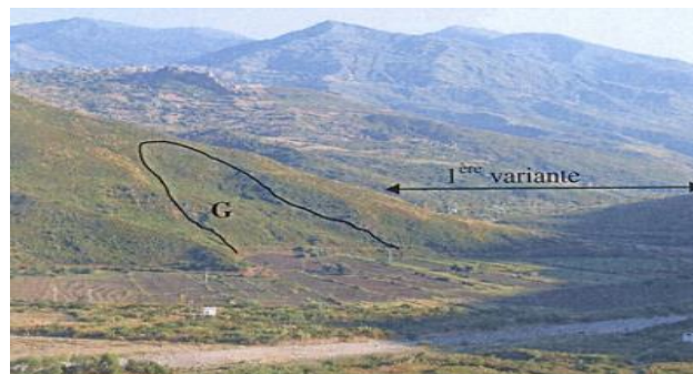
Figure 4.11 : Glissement de terrain (G) au droit de la galerie de dérivation sur la 1 ère variante de la retenue [45]
