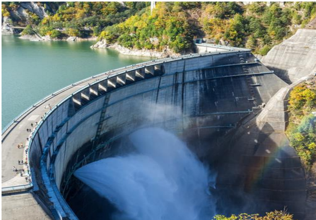
Figure 1.4 : Barrage voûte [6].
