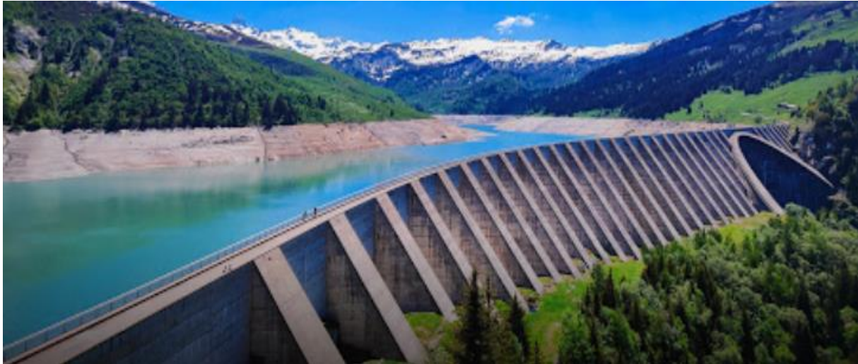
Figure 1.3 : Barrage à contrefort [5]
