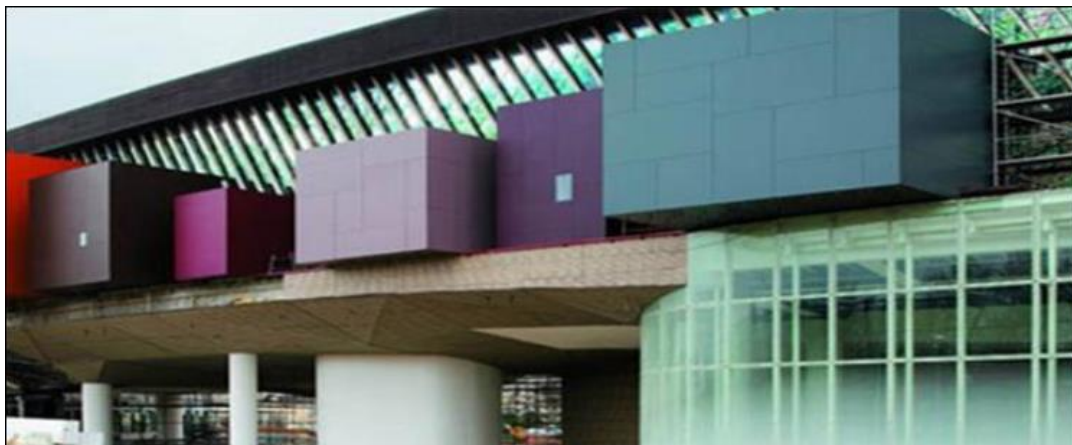
Figure 97 : boîtes en saillies sur la façade nord. Source : http://www.wikipédia.com
