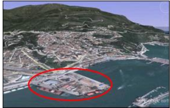
Figure 48 : l'assiette d'intervention (vieux port). Source : Google earth traité par les auteurs.
