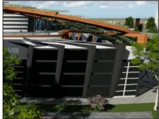
Figure 145 : brises soleils horizontaux côté Est. Source : auteurs.
