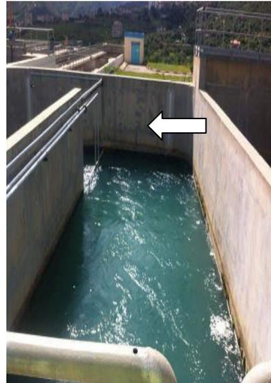
**Figure (13)** Injection de l'acide Sulfurique.
