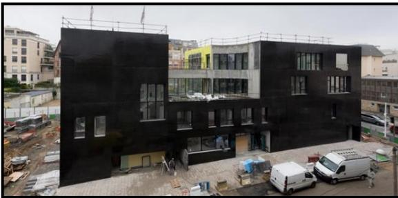
Figure68 : Enceinte en béton auto-plaçant noir
