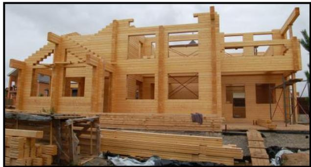
Figure106 : Construction avec du bois massif
