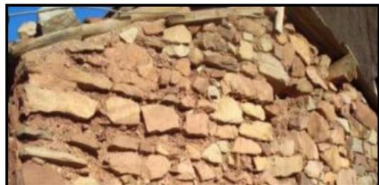
Figure 15 : Utilisation du matériau terre comme mortier.
