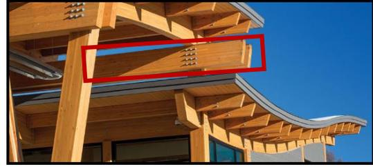
Figure111: Poutre en bois lamellé collé
