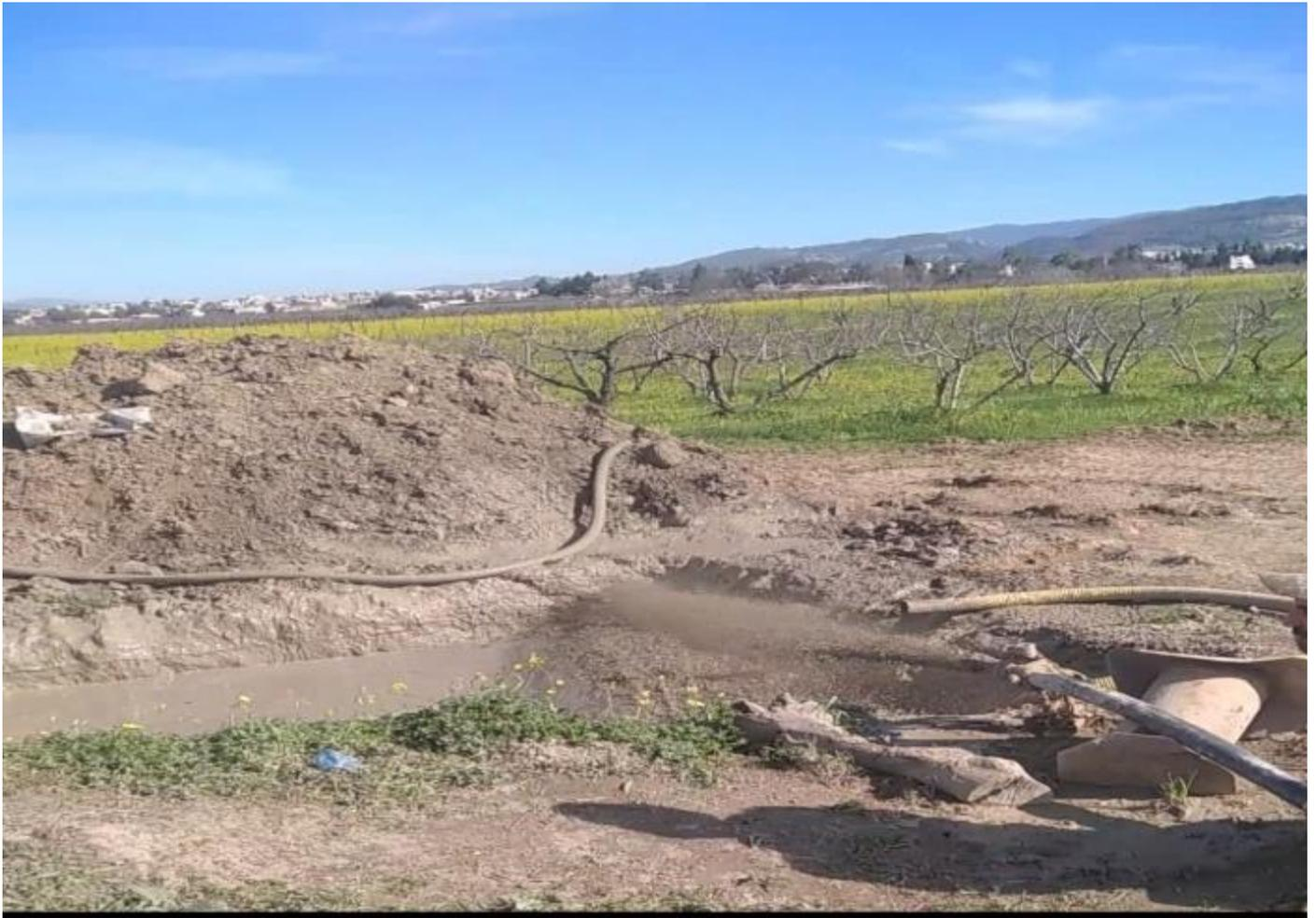
*Figure 28 : développement au système d'Air-lift.*
