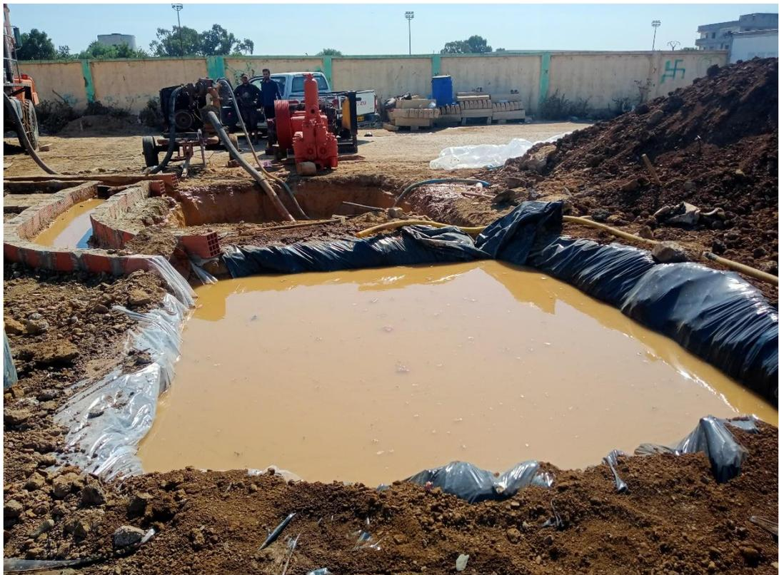
*Figure 31 : bassin de boue et rigoles.*
