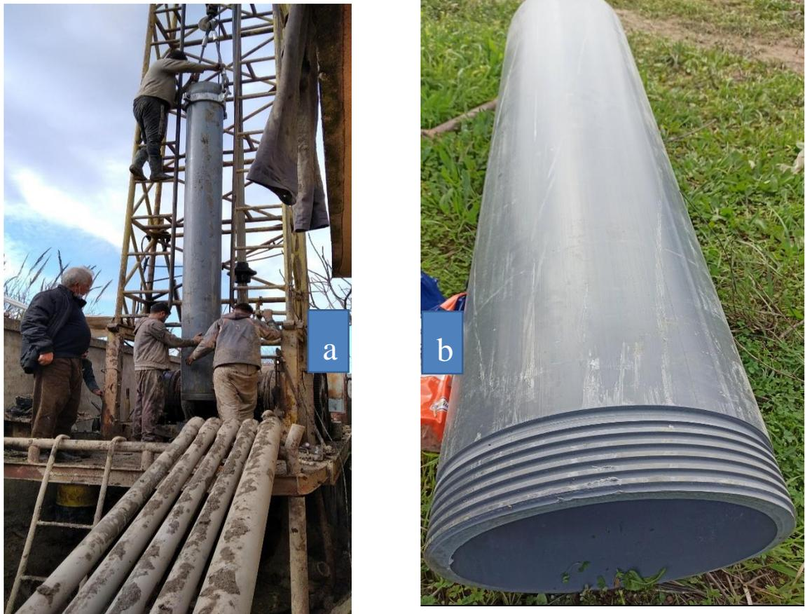
*Figure 40 : mise en place du tubage.*
