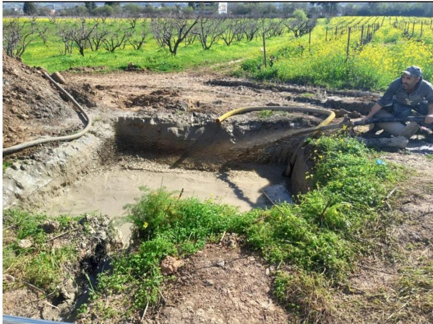
*Figure 43 : sortie d'eau à haute pression avec des déblais.*
