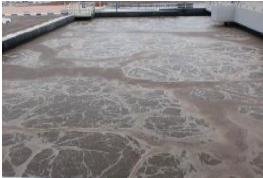
Figure 5.3 : Bassin d'aération.
