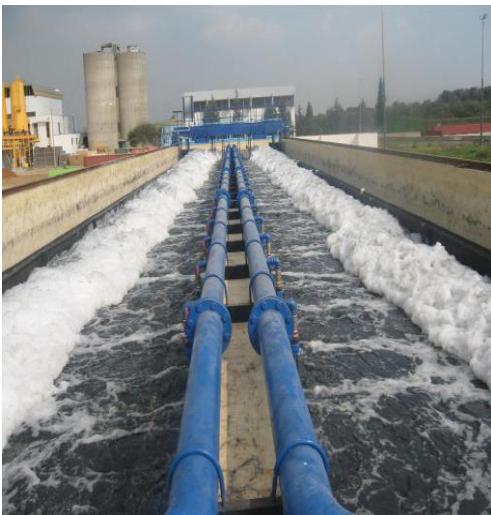
Figure6.6: Déshuileur dégraisseur de la STEP de BARAKI.
