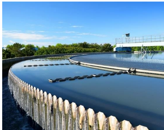
Figure 5.5 : Bassin de désinfection.
