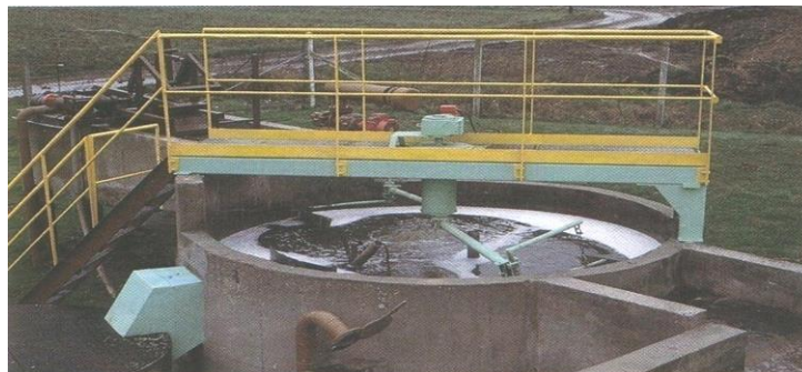
Figure6.5 : Déssableur cylindro-coniques a admission tangentielle.
