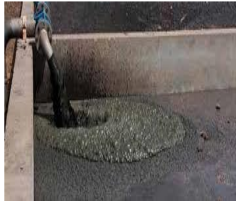
Figure 5.7 : Lit de séchage.
