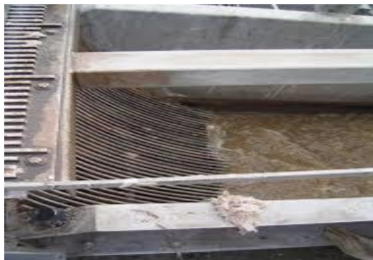
Figure 5.1 : Dégrilleurs fins à tambour rotatif.
