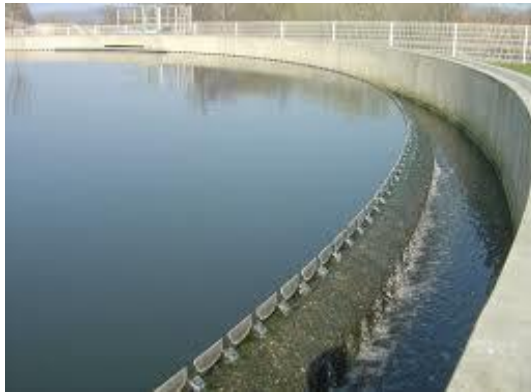
Figure 5.4 : Clarificateur.
