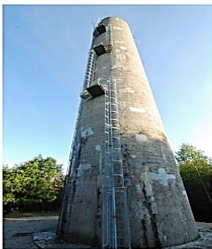
Figure VI.13 : cheminées d'équilibre sur une conduite de refoulement
