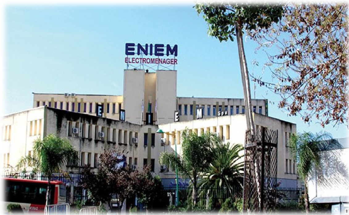
Figure 1:Siège de l'Entreprise Nationale des industries électroménagères
