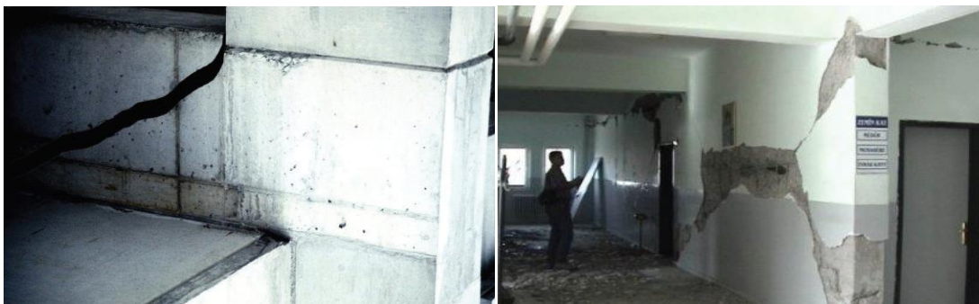
Figure I.3 : Rupture en cisaillement de la poutre. Figure I.4 : Rupture en cisaillement du mur (séisme à BİNGÖL (TURKEY) 01/05/2003)
