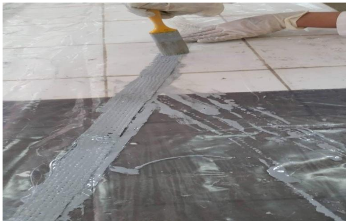
Figure II-13 : Bande de tissu de verre imprégnée de résine.
