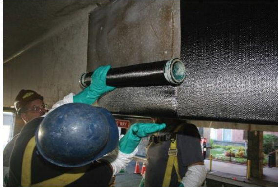
Figure I.5 : renforcement au cisaillement de la poutre [19].
