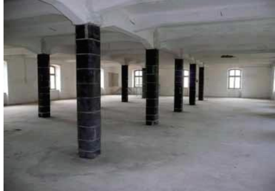
Figure I.8 : renforcement par confinement de poteaux
