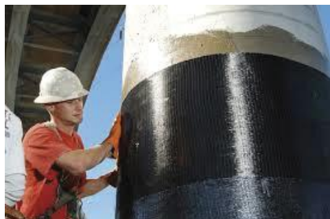
Figure I.7 : L'application circonférentielle de renforts
