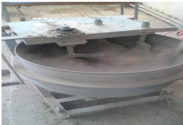
Figure. II.5. Malaxage du béton.
