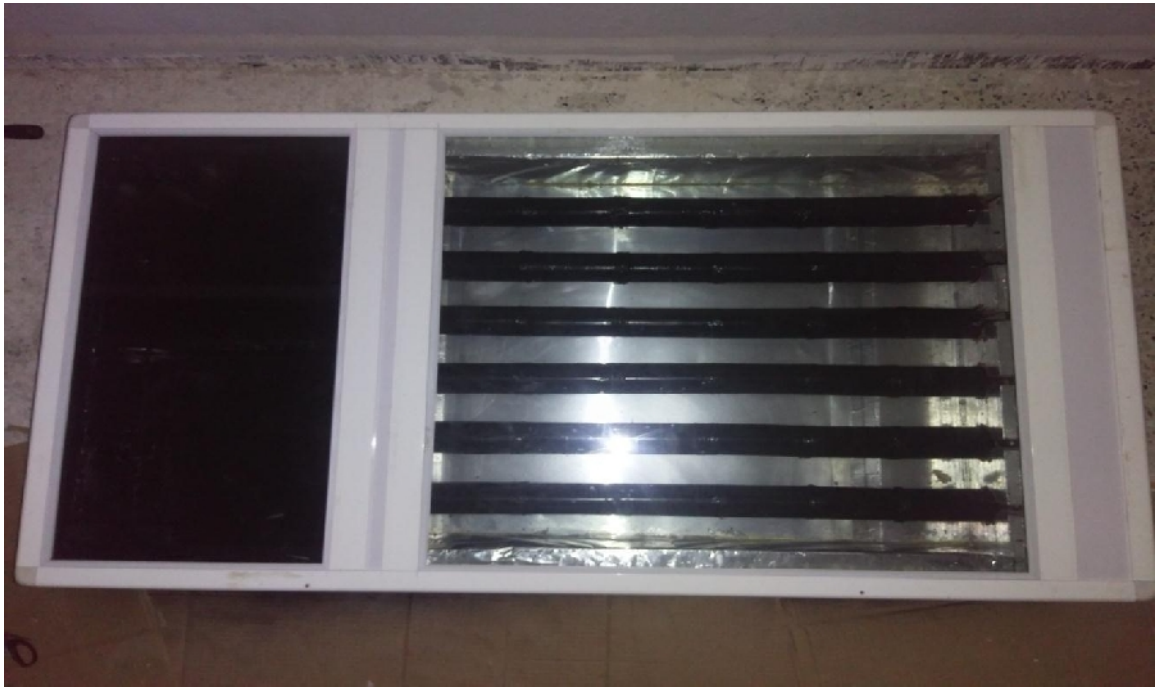
Figure IV.28 : Réalisation du double vitrage
