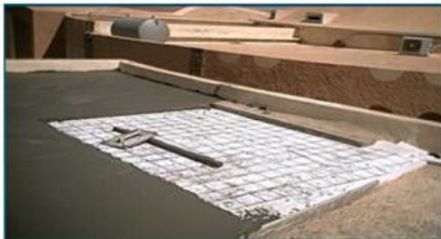
**Photo 2.3 : isolation extérieure de la toiture**
