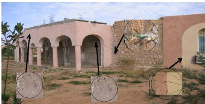
Photo 2.8 : Différents thermocouples placés à l'extérieur du local (toiture extérieure, mur ouest extérieure, au niveau des différentes profondeurs au mur, sur la surface extérieure du mur ouest au local adjacent pour une étude comparative).
