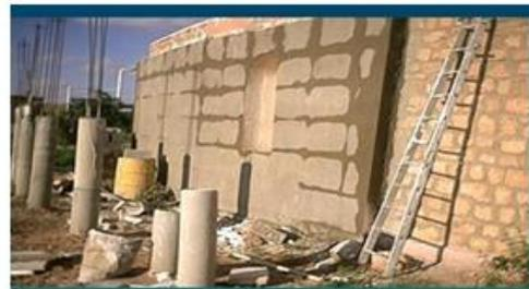
**Photo 2.4 : isolation extérieure du mur ouest**
