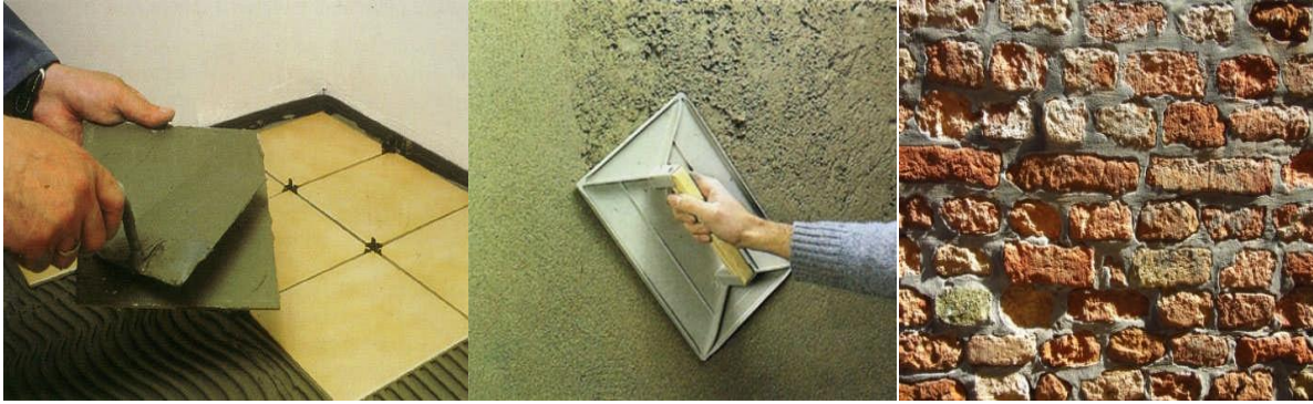
Figure I-6 : (a) mortier acoustique, (b) mortier de finissage, (c) mortier de maçonnerie
