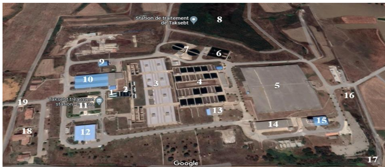
Figure 6 : Aperçu général de la station de traitement d'eau potable TAKSEBT
