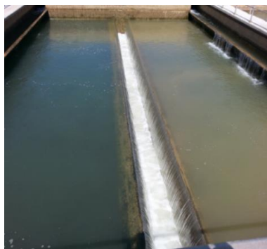
Figure I.8 : Les filtres AQUAZUR V.
