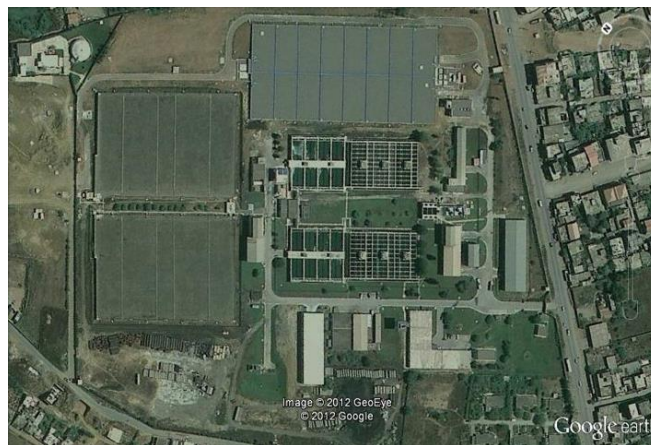
Figure I.1 : Implantation de la station de traitement de Boudouaou.
