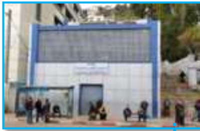
Figure 37 : Station téléphérique El-Madania Source : auteurs
