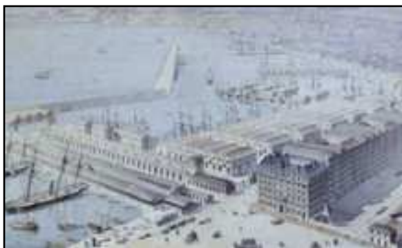
Figure 8: Vue d'ensemble sur les bâtiments des Docks et le port. Source : Marius.marseille.fr
