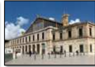
Figure 19 : gare Saint-Charles Source : google image
