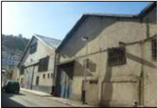
Figure 22 : Hangars transformé en atelier Source : Google image
