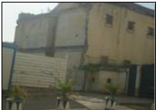
Figure 25 : Bâts en ruine Source : Google image
