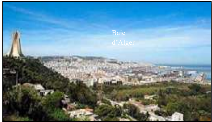
Figure 1: Vue sur le quartier d'El-Hamma Source : Google image.
