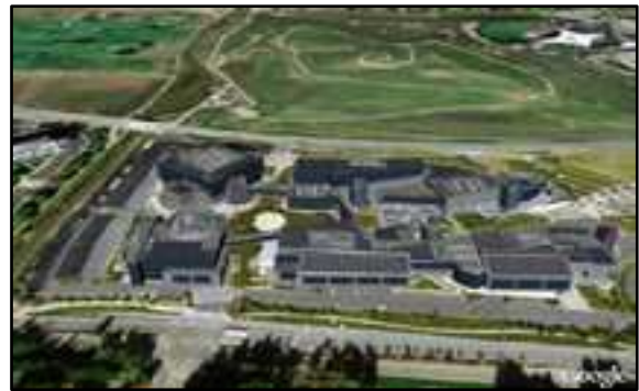
Figure 5 : vu d'ensemble sur le Googleplex Source : http://clivewilkinson.com/pdfs/CWACaseStudy_GoogleplexANewCampus
