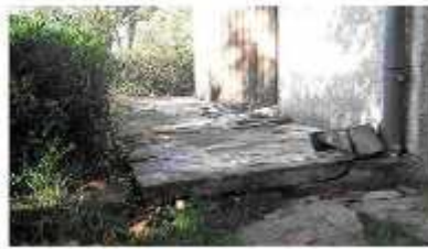
Figure II.26 : Désordres de la structure au cours des périodes de sécheresse (Région bordelaise).
