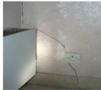
Figure II.26 : Désordres de la structure au cours des périodes de sécheresse (Région bordelaise).
