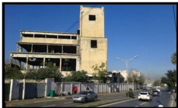
Figure 38 Friche industrielle (usine de cooke) Source : Auteurs
