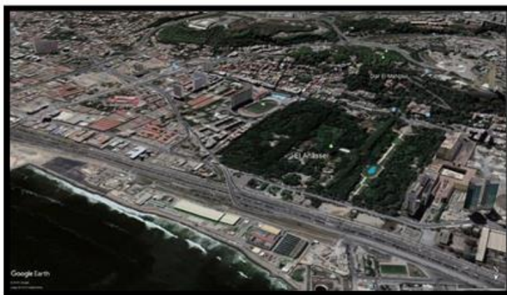
Figure 36 Vue d'ensemble sur le quartier des Annassers
