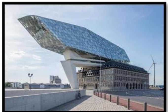
Figure 53 Maison du port de ZahaHadid Source : chroniques-architecture.com
