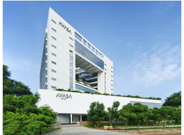
Figure 83 : Vue sur l'entrée de l'Hôtel Avasa Source : http://new.rushi.net/
