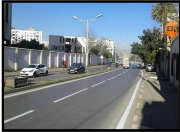
Figure 30 Chemin FernaneHanafi Source : Auteurs
