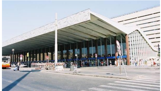
Figure 71 : Gare de Termini Source : www.structurae.net
