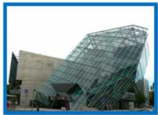
Figure 72: accès piéton de côté Sud au cinéma
