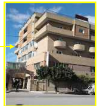
Figure40 : hôtel concorde Source : auteur ; Janvier 2018
