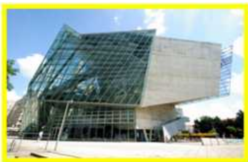
Figure73 : accès piéton au cinéma du côté Sud
