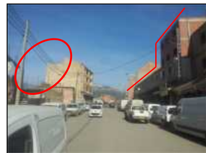
Figure27 : Photos sur la rue Outaleb Amar. Source : Auteur, Janvier2018
