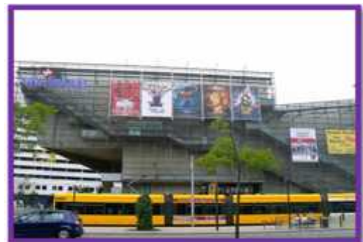
Figure 74: station de tramway du coté Nord de cinéma
