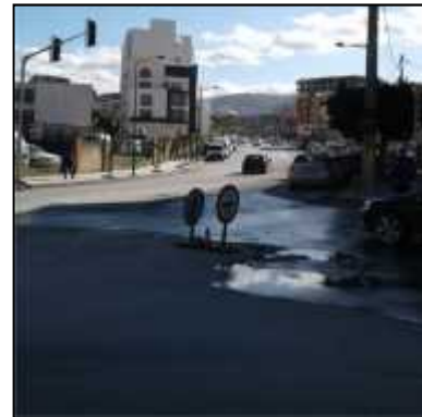
Figure37 : photos du nœud l'Ex Marché de Gros
