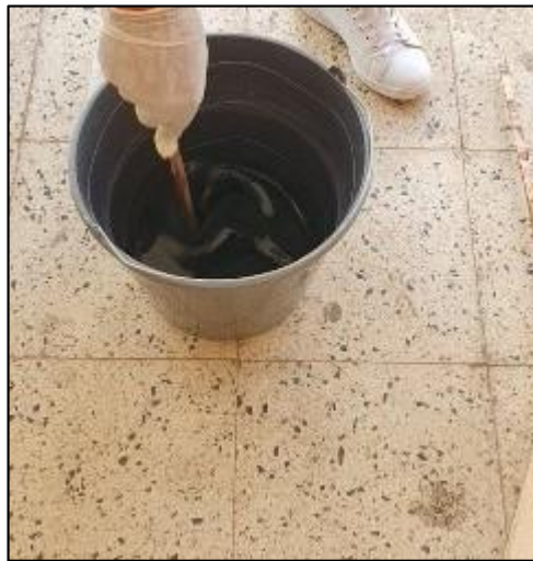
Figure III.12 : Mélange de la résine polyester avec le catalyseur RP50
