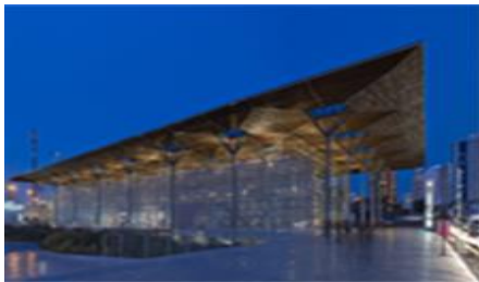
Figure 9 Vue Sur le Projet Source : Archilovers.com
