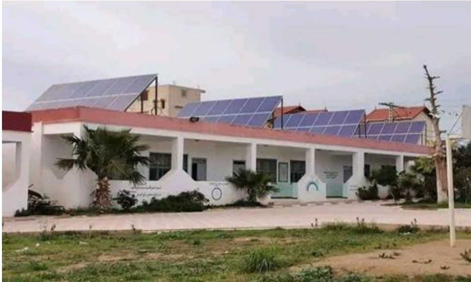
Figure 13: Panneaux solaires « SPS »
