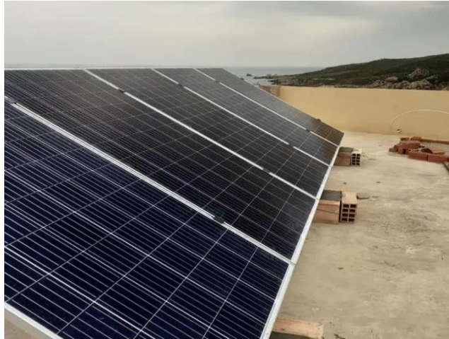
Figure 30:: Installation d'un générateur solaire.
