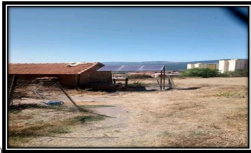
Figure 15: installations des panneaux solaires dans une forme agricole AVENYHYD
