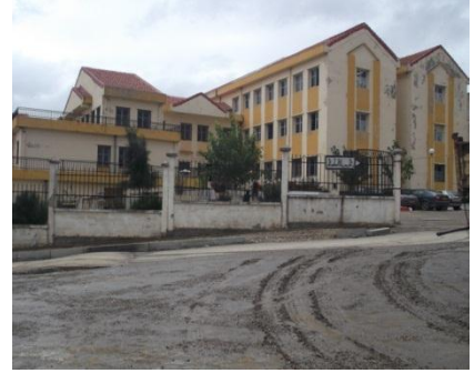
Figure 43 : Lycée de yakouren, source : l'auteur
