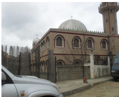
Figure 44 : mosquée al Chahin, source : l'auteur
