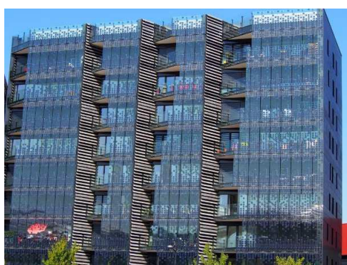
Figure 159 : Immeuble Hikari Lyon – France source : http://www.sadev.com
