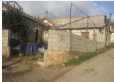
Figure 38 : Cité 5 juillet source : l'auteur
