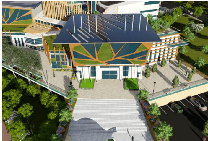
Figure 116: porche d'entrée Source : l'auteur
