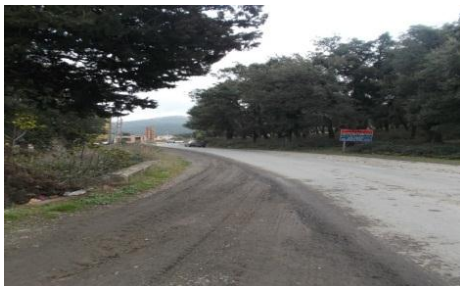
Figure53 : Entrée de Tizi à l'Ouest source : l'auteur
