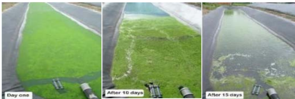
Figure I.10 : Utilisation de micro algues pour le traitement des eaux usées
