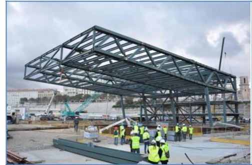
Figure 118: Structure centre régional Marseille
