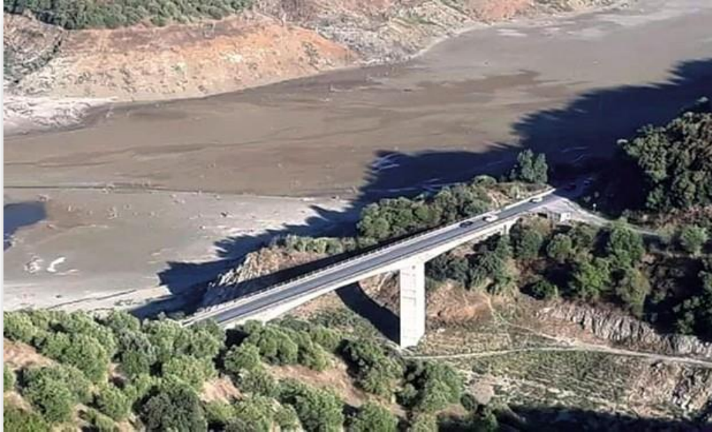
Figure I.2 Barrage de Taksebt Mars 2021 rempli à 25%
