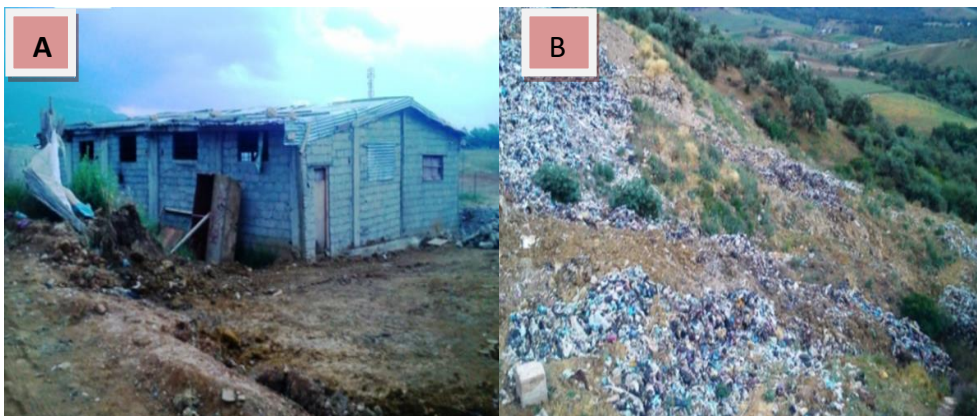
Figure 20 : (A) Vue extérieure de l'étable, (B) Décharge à proximité de l'étable
