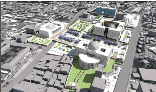
Figure40 : Nouveau siège des deux chambres du parlement. Source : PDAU 2011
