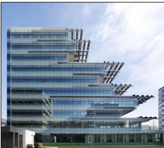
Figure158: Exemple de référence : la SIEEB en Chine ó Mario Cucinella Source : Guide de l'éco-construction PDF.
