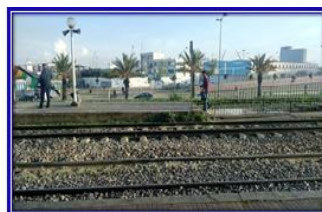
La voie ferroviaire
