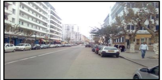
Figure 26 : Vue sur la rue Aissat Idir. Source : Auteurs.
