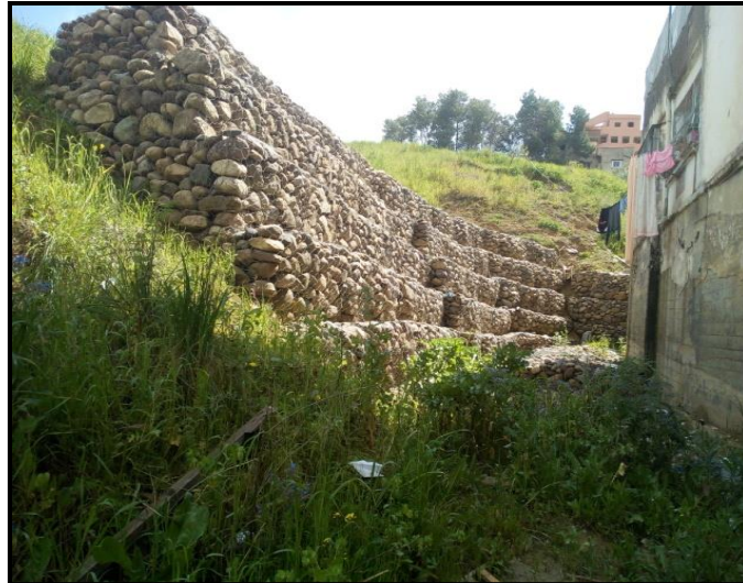
Figure III.2. Réalisation de mur de soutènement sur le site étudié
