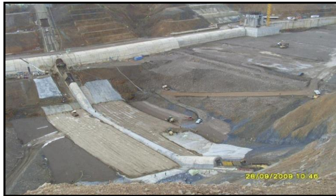
Figure II.4. Stabilisation par compactage de surface (Cas d'une digue de barrage en terre de Kef-Eddir construit à Tipaza, Algérie)
