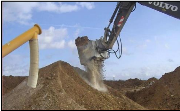
Figure II.14. Malaxage de sol avec le ciment
