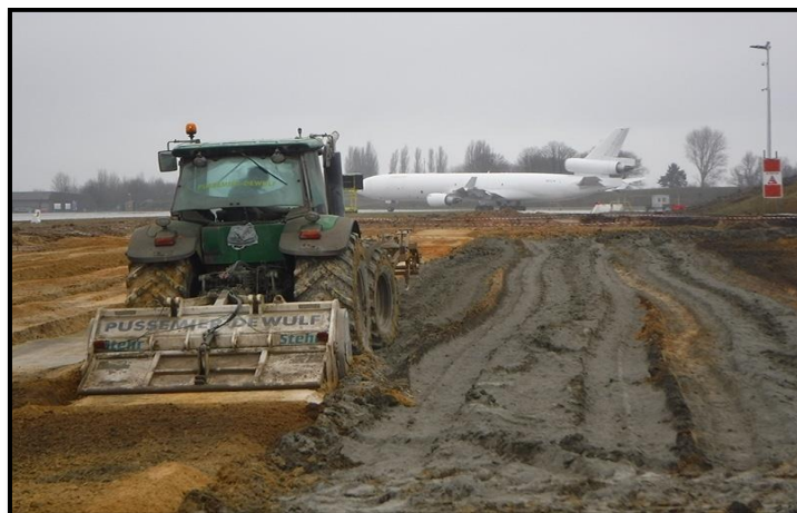
Figure II.15. Mise en œuvre de sol ciment
