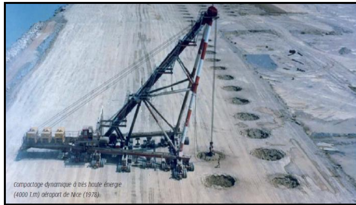
Figure II.5. Densification d'un terrain par compactage dynamique (cas réel de l'aéroport de Nice 1978, France).
