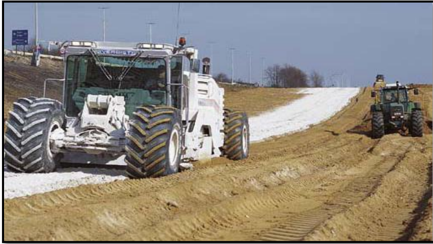
Figure II.11. Traitement par malaxage
