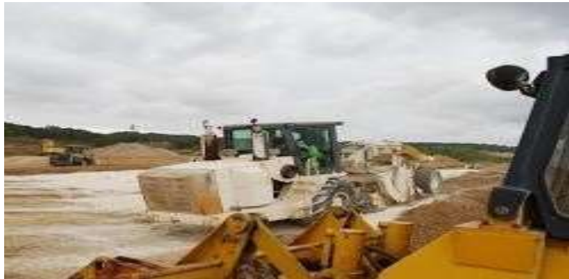
Figure II.21. Malaxeurs pour traitement des sols argileux.
