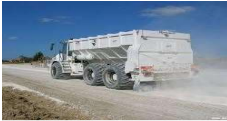
Figure II.20. Épandeurs pour traitement des sols argileux.
