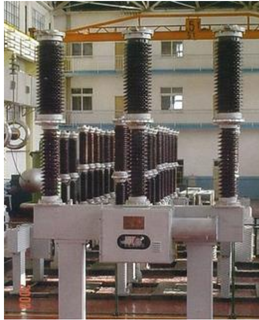
Figure II.3 : disjoncteur SF6 à l'hexafluorure de soufre.
