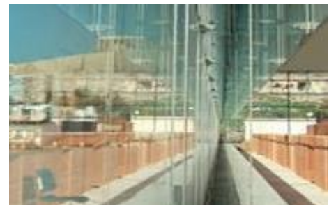
Figure II-21: Le vitrage utilisé dans le musée. Source : nouveau musée de l'acropole PDF.
