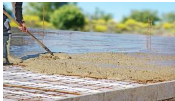
Figure 0-39: la pose du béton. Source : https://www.travaux-maconnerie.fr
