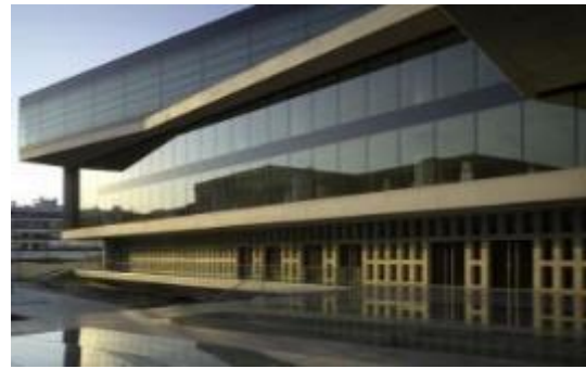
Figure II-18: la façade vitrée du musée d'Athènes. Source : https://www.miesarch.com/work/467
