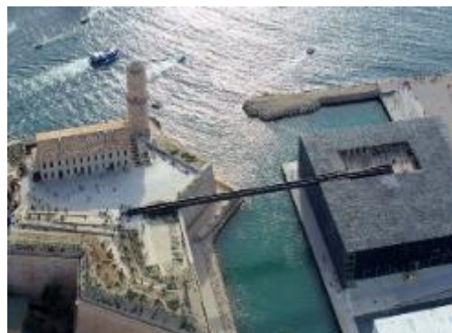
Figure II-32: Vue aérienne du complexe.
