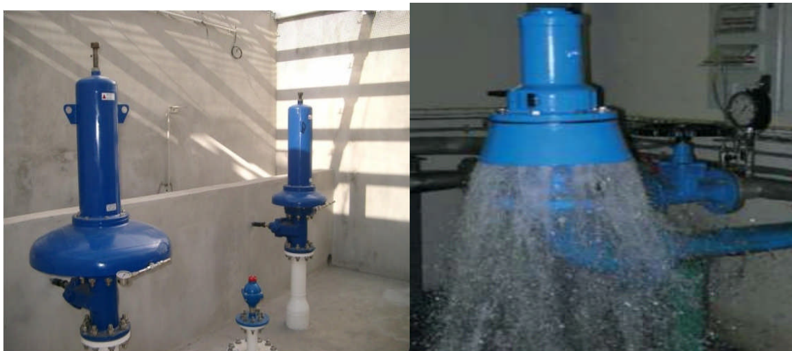
Figure II. 2: Soupape de décharge.
