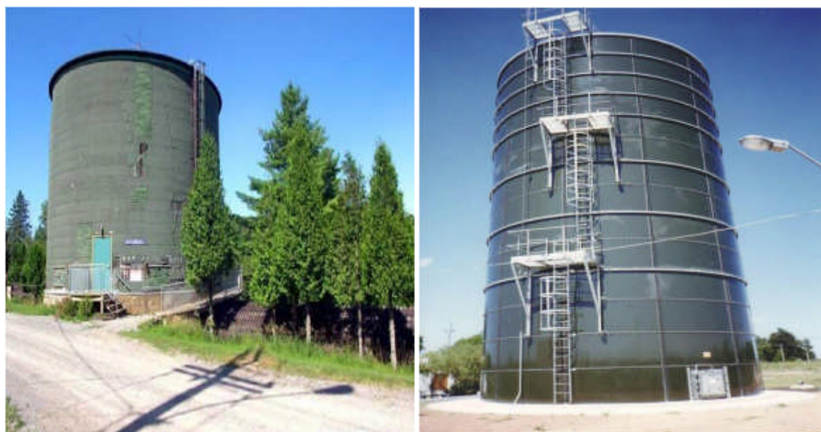
Figure II. 5: Cheminée d'équilibre Figure II. 6: Cheminée d'équilibre à Montevideo, Uruguay. de St-Alban, Québec.
