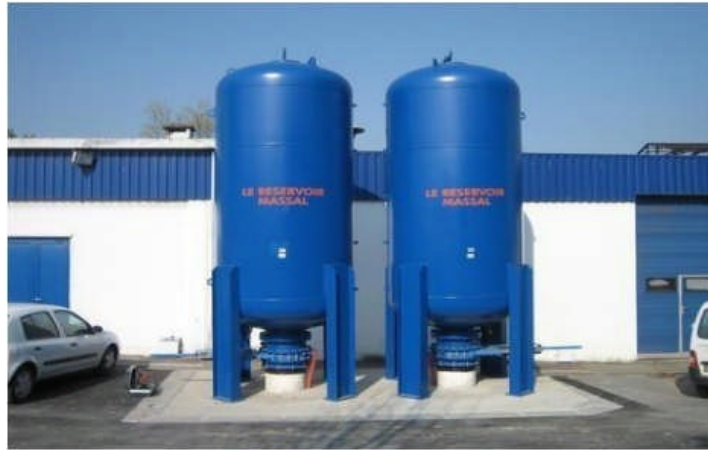
Figure II. 11: Réservoir d'air.
