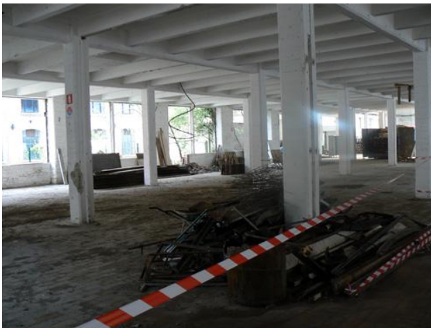
poteau en béton armé pour l'infrastructure
