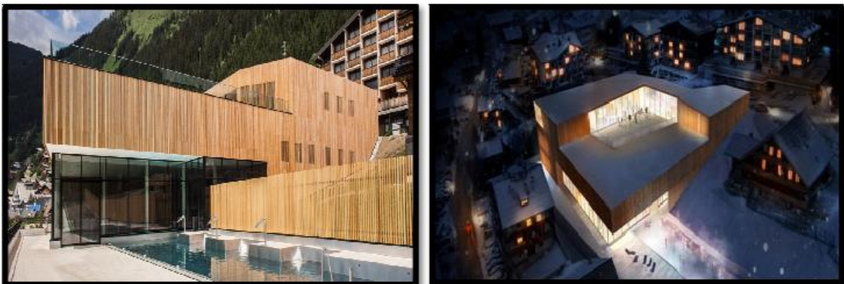
Centre de loisir de châtel Source: PDF centre aquatique de châtel.
