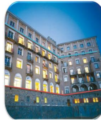
Fig.29 : La façade d'hôtel d'origine.
