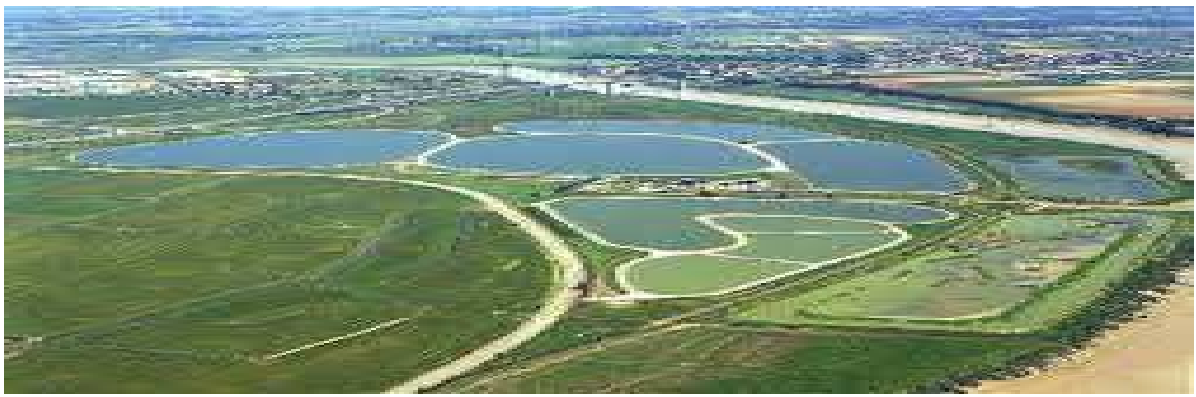
Figure II.2 : Vue aérienne de la station de lagunage [28].
