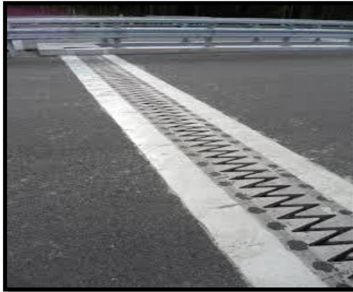
*Figure IX.2. Joint du type Wd (souffle moyen)*
