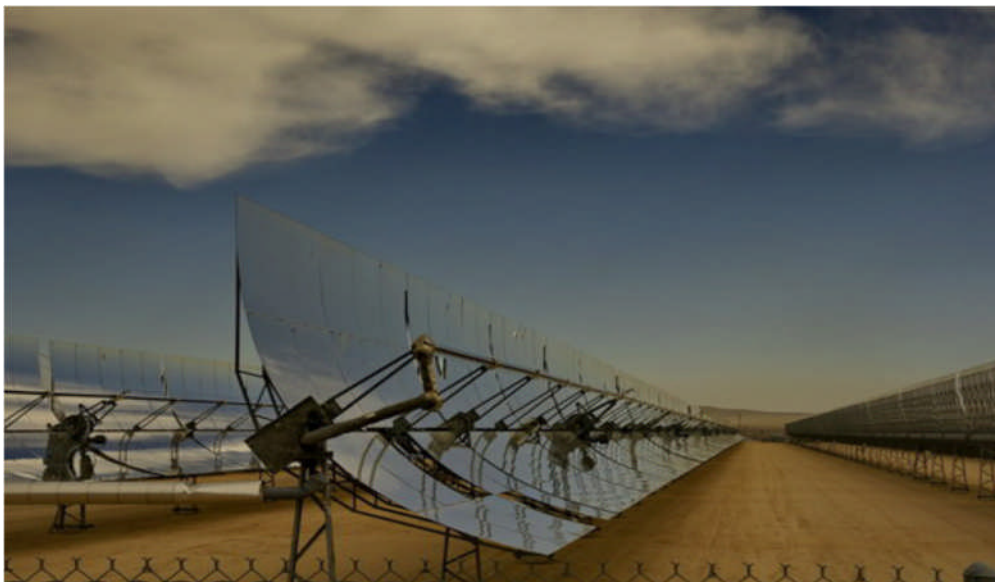
Figure.II.7 : Concentrateur à capteur cylindro-parabolique. [5]
