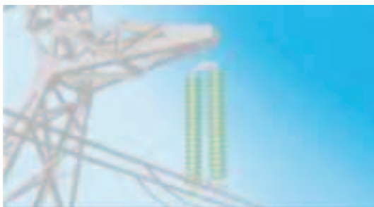
Fig. I.15 Chaîne droite
