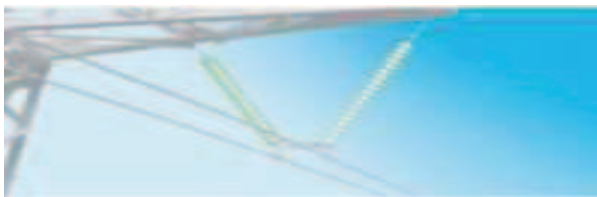
Fig. I.14 Chaîne en V
