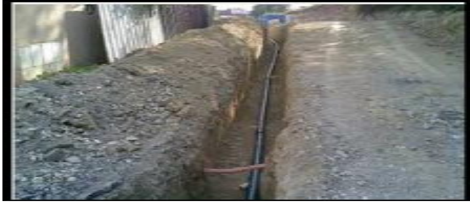
Figure(IV.1) : pose des conduites en terre
