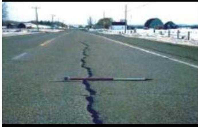
Figure III.21: Les fissures longitudinales.
