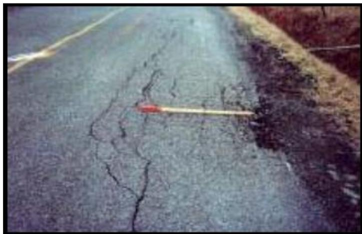
Figure III.17: Une chaussée affaissée.
