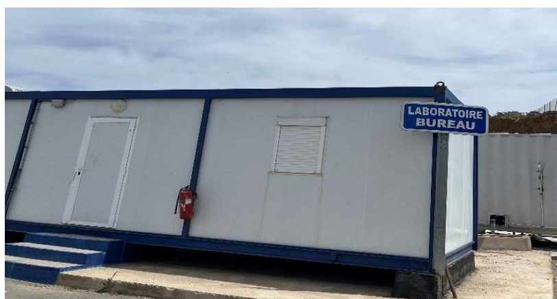
Figure 19 : Bureau technique et laboratoire de contrôle (Originale, 2025)
