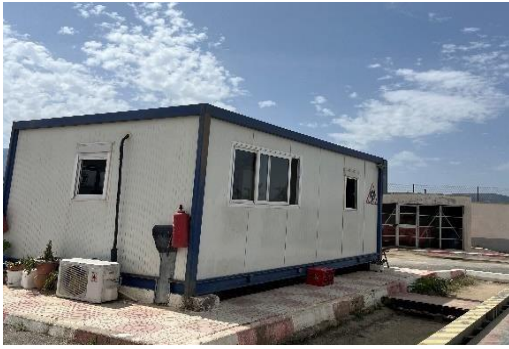
Figure 06 : Le poste de contrôle (Originale, 2025)
