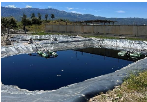
Figure 14 : Bassin d'homogénéisation (Original, 2025)
