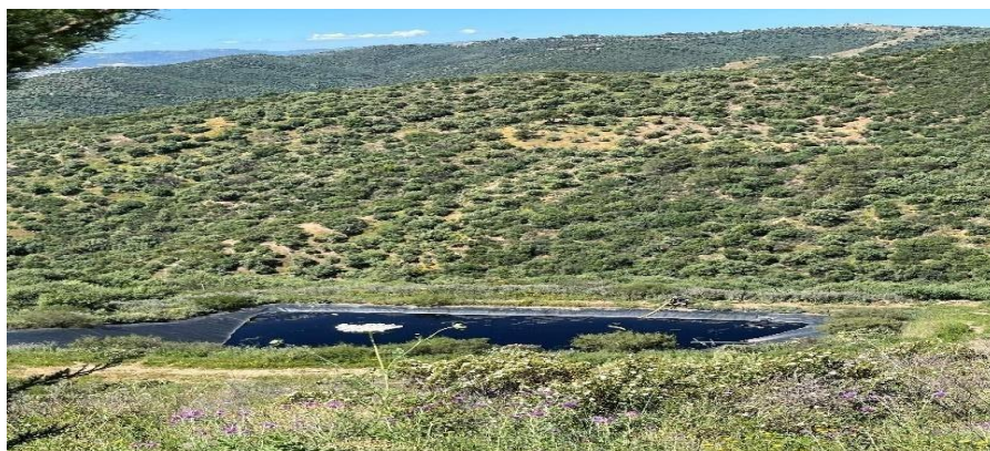
Figure 13 : Bassin de rétention des lixiviats (Original, 2025)
