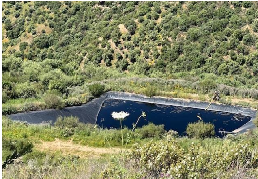
Figure 02 : Bassin de stockage du lixiviat de la décharge de Boghni (Originale, 2025)
