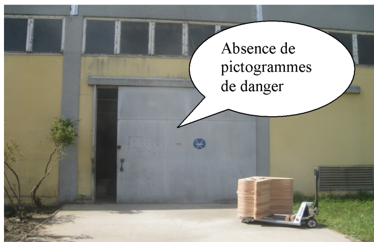
Photo 23 : Atelier de production de bois
