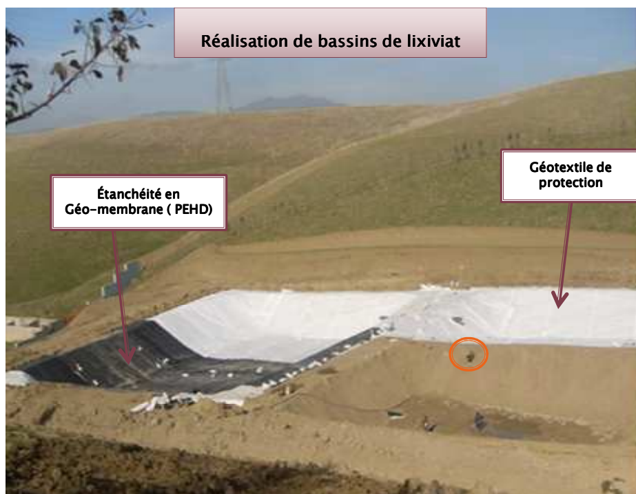
Photo n°16 : La réalisation des bassins de lixiviat au niveau d'un CET .
