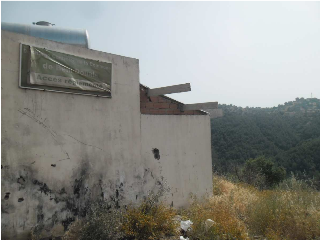
Décharge de Béni Douala en voie de réhabilitation par L'EPW-CET
