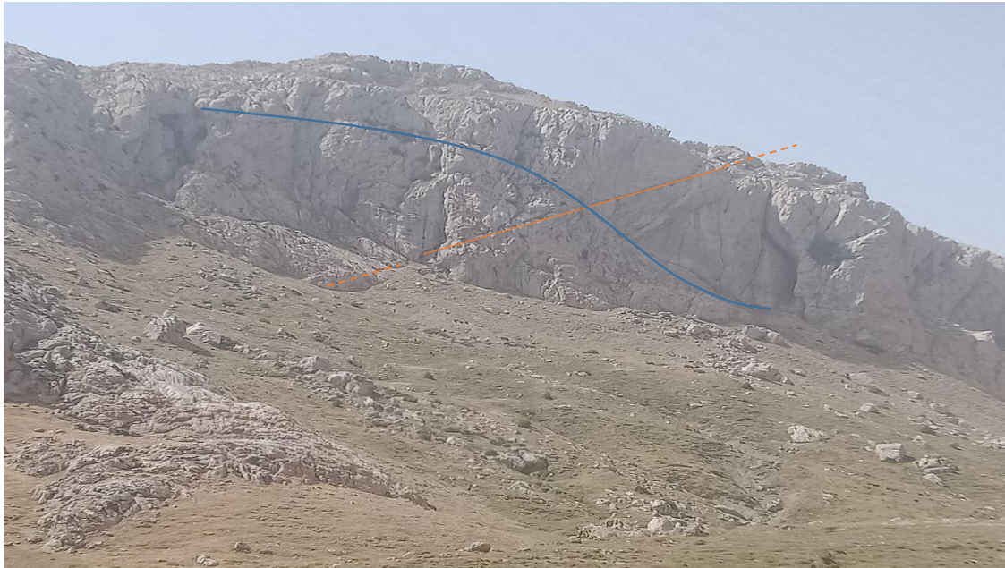
Figure 2. 9: Photo prise d'un ensemble de faille affectée le massif.
