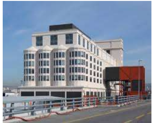
Figure 100:Le Silo d'Arenc.
