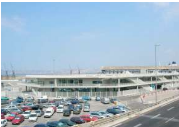
Figure 7: La nouvelle gare maritime en face de la Major.
