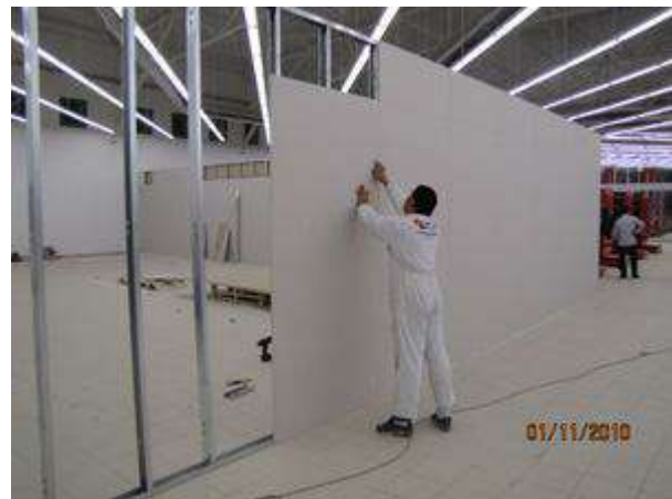
Figure 152: cloisons intérieures.
