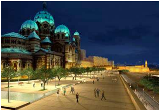
Figure 96 : La Cathédrale de la Major après réaménagement
