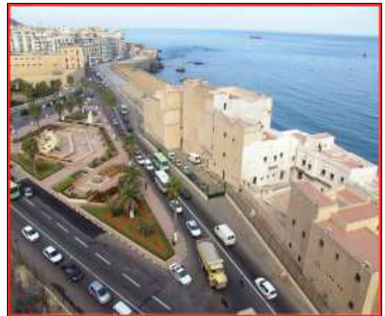
Figure 130: La place avant l'intervention.
