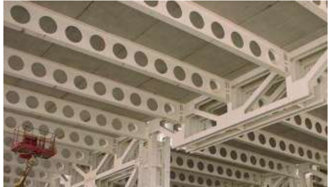
Figure 150: poutre alvéolaires.
